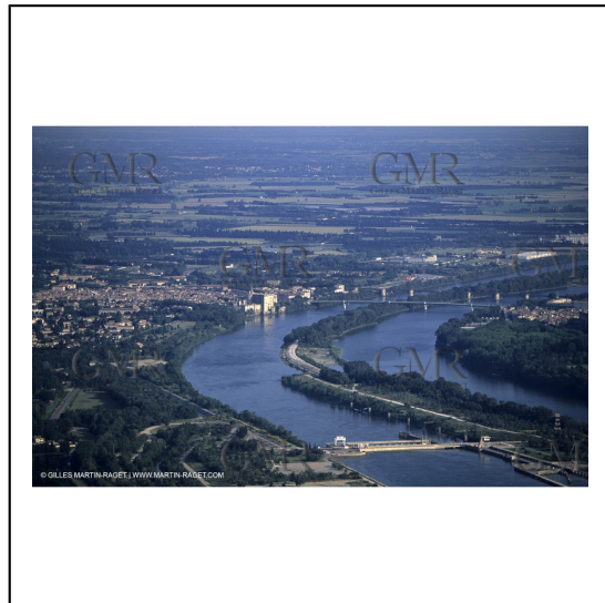
Le Rhône, Barrages de Vallabrègues et Tarascon***Rhône river, Vallabrègues barrage and Tarascon
