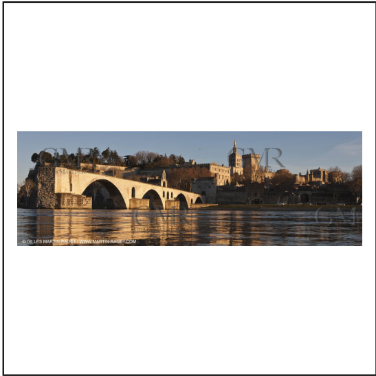
2012, Avignon (FRA,84), Palais des Papes, Pont Saint Benezet***2012,Avignon (FRA,84), Popes palace, Saint Benezet bridge
