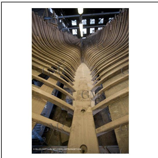
27/11/2007 - La Ciotat (FRA, 13) - Restauration de Mariska aux "Charpentiers réunis"***27/11/2007 - La Ciotat (FRA, 13) - Mariska refit at "Charpentiers Réunis" boatyard
