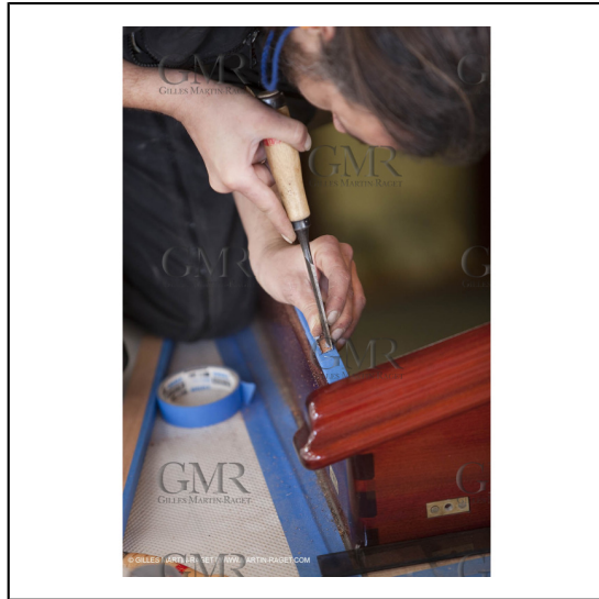
13/03/2010 - La Ciotat (FRA,13) - Mariska - finitions au Charpentiers Réunis***13/03/2010 - La Ciotat (FRA,13) - Mariska - finitions au Charpentiers Réunis
